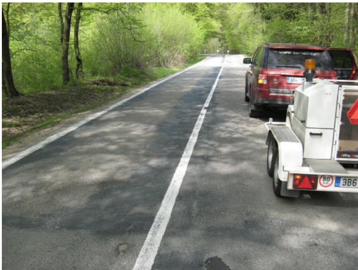
F29, km 1,295+ Změna povrchu, hlubková koroze, vysprávký.
