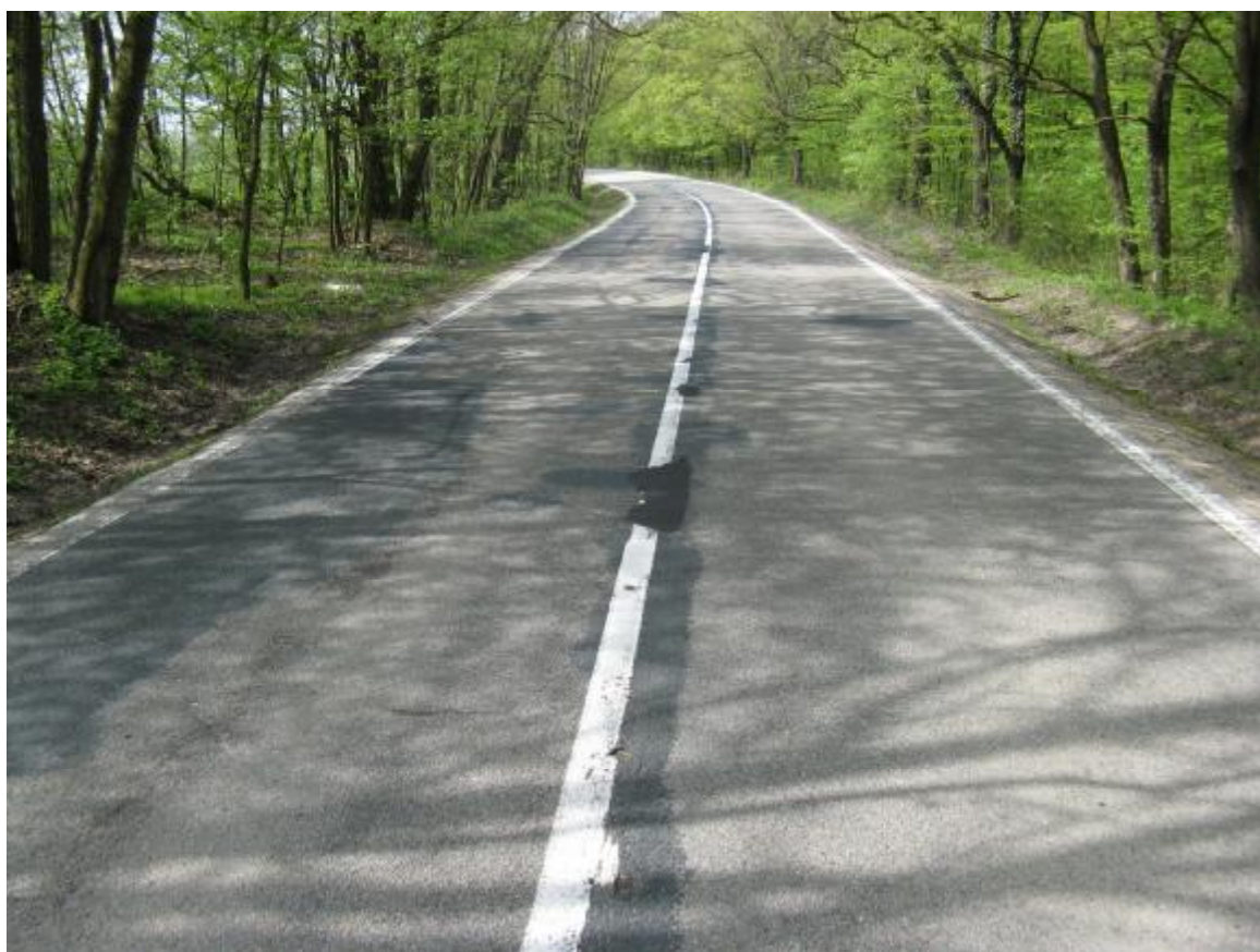
F63, km 3,110+ Síťové trhliny u okraje s vysprávkou, hloubková koroze.
