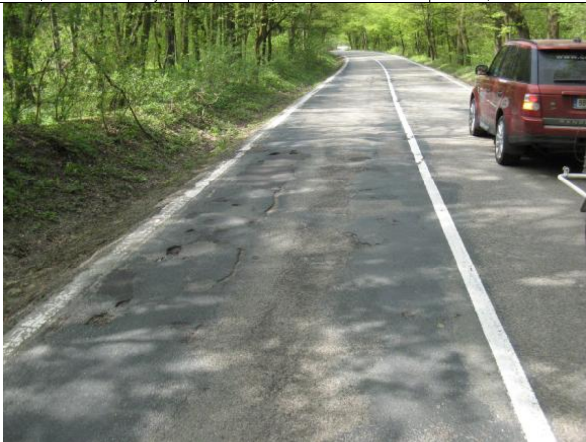
F58, km 2,900+ Síťové trhliny u okraje, vysprávký, hloubková koroze.
