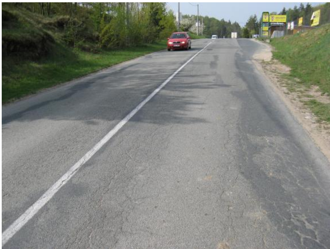
F02, km 0,010+ Síťové trhliny.
